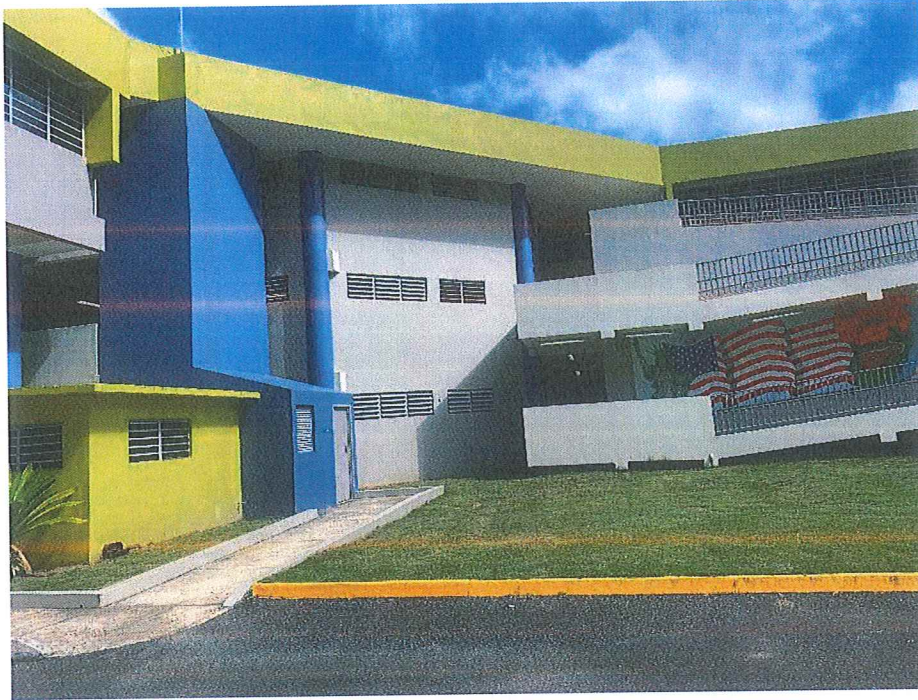
Foto 1: Vista de la fachada de la escuela.
