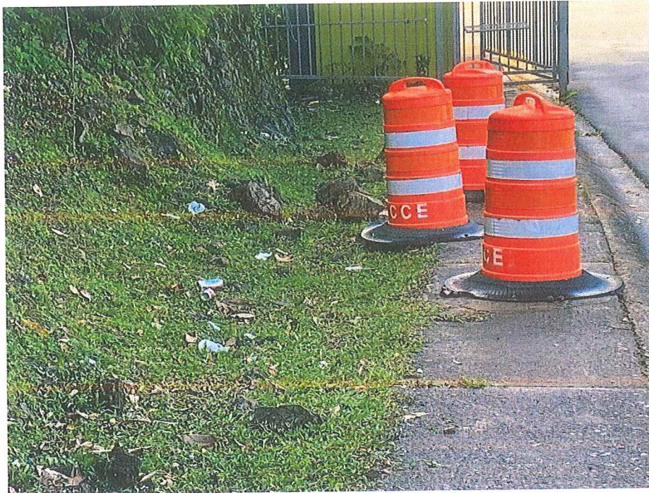
Foto 3: Se observaron unas rocas que cayeron del talud sobre la acera en la entrada de la escuela que deben ser removidas antes de comenzar las clases.
